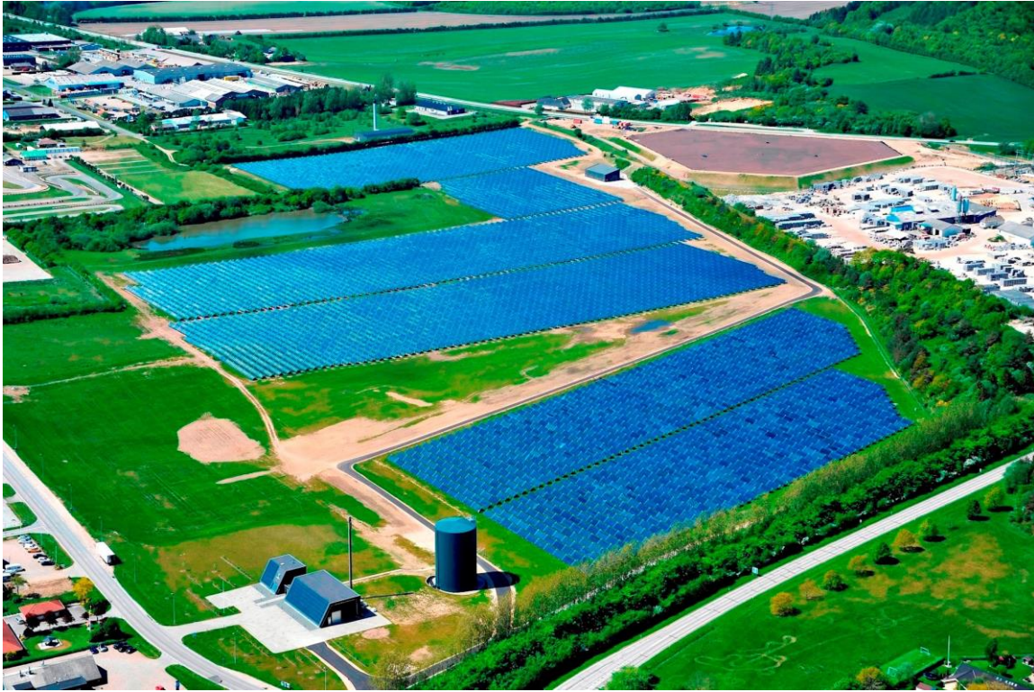
Abb. 23: Solarthermieranlage mit rd. 200.000 m 3 Erdbeckenwärmespeicher (Wärmespeicher oben rechts im Bild/ Bild: www.vojensfjernvarme.dk )
