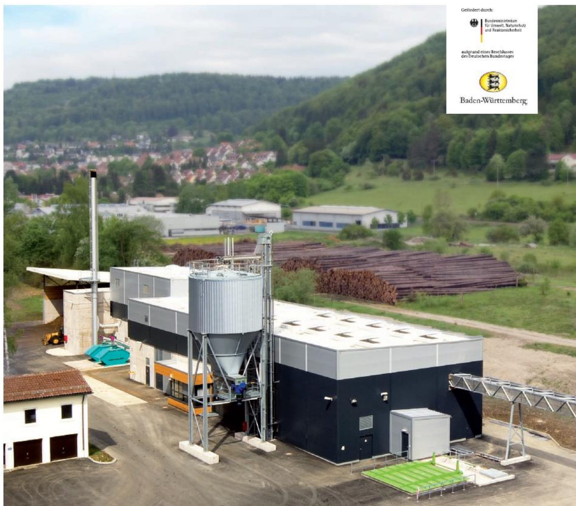
Abb. 26: Biomasse-HKW Kläranlage Ebingen (Bildquelle: Klärschlammverwertung Albstadt GmbH)
